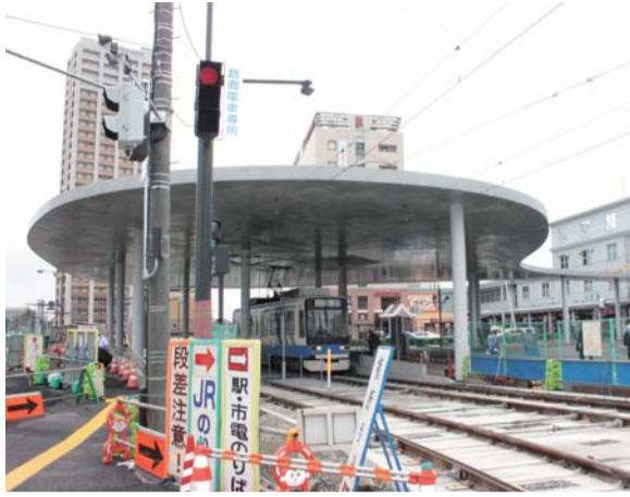
▲大屋根が完成した熊本駅東口広場
