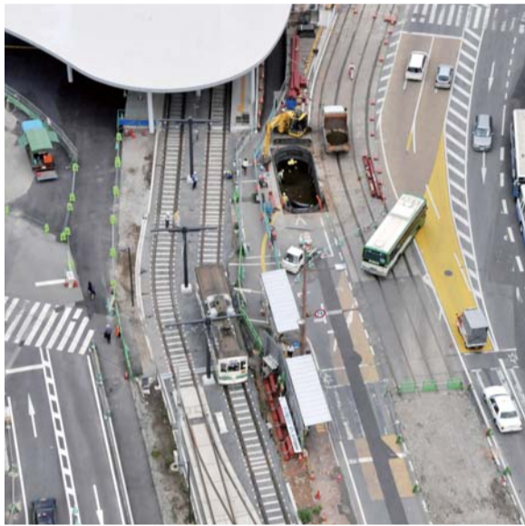
▲熊本駅前を進む車道中央の旧軌道を撤去する工事
