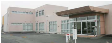
▲「ノバリスTx」の導入に併せ治療棟を増築した(写真左手の2階建て部分)。増築部は鉄筋コンクリート造り一部2階建て、延べ床面積462㎡。コンクリートに厚みを持たせ、建物全体で220トンの鉄板を使用するなど安全面に配慮している
