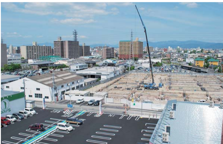
▲現在建設が進められている東側用地。オープンは今秋の予定
