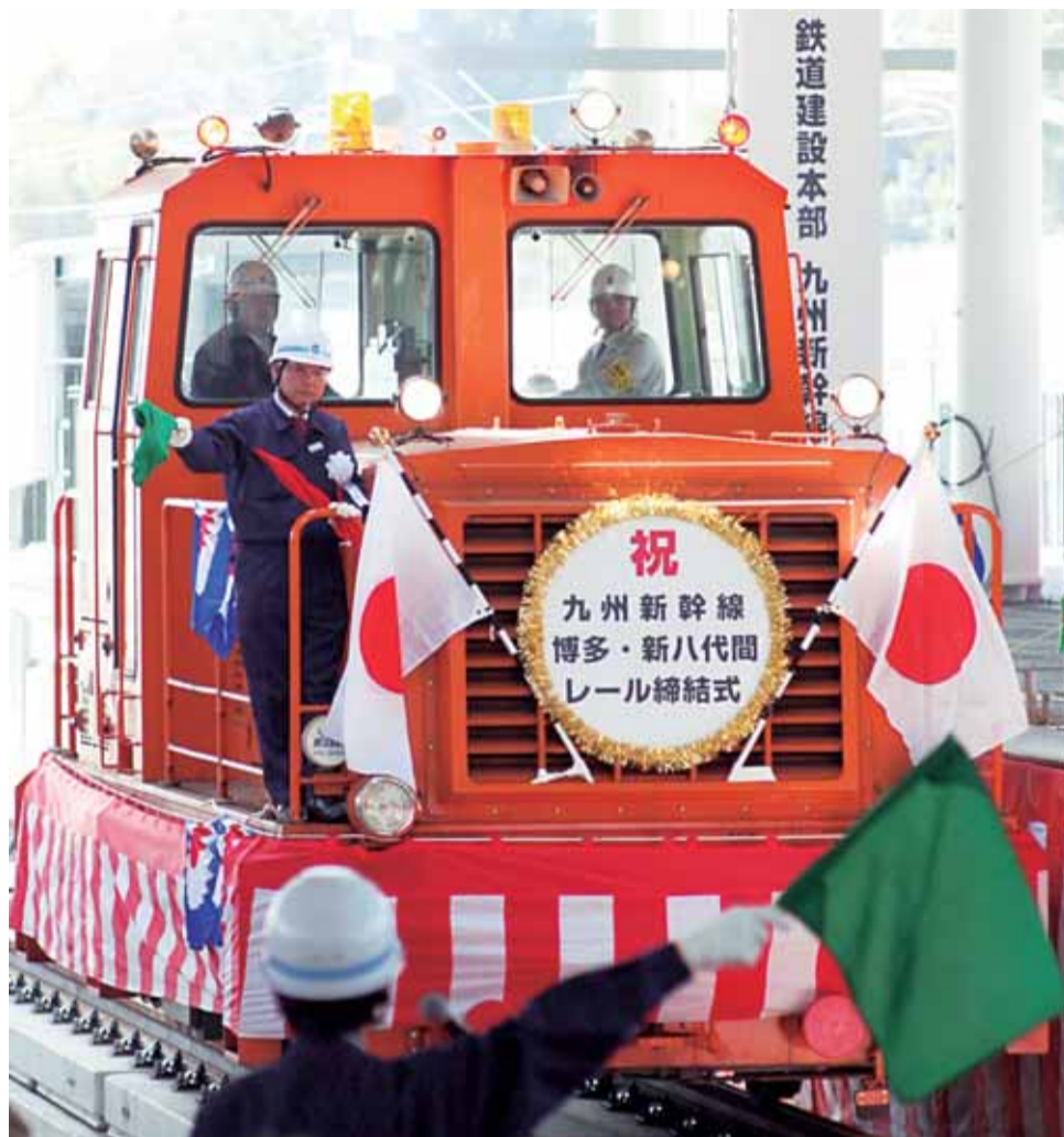
レール締結後、鉄道・運輸機構の外山寛宇鉄道軌道建設所長の指揮で新幹線軌道を走行する「モーターカー」（軌陸車）
