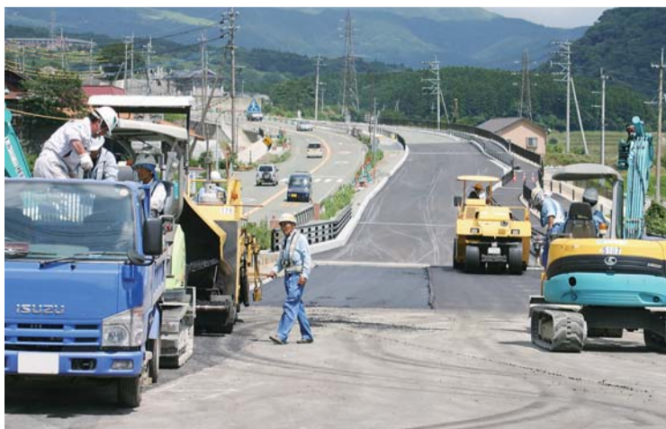
▲炎天下の中、立野小付付近で進む舗装工事
