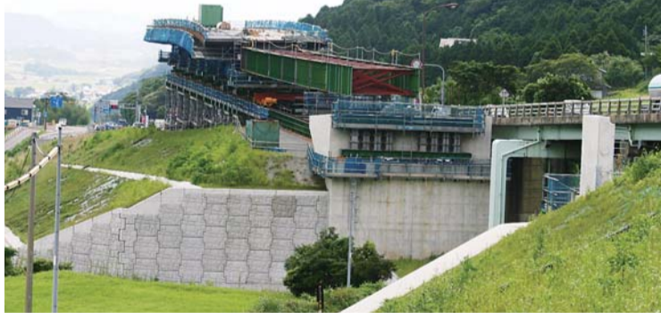
▲阿蘇側から見る製作中の「立野跨線橋」。写真手前を豊肥線が走り、その上をまたいで架けられる
