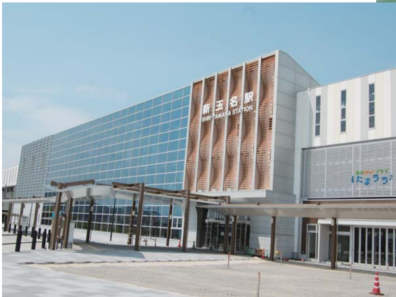
▲ガラスの壁面を木立をイメージした柱列が印象的。駅隣接の高架下(写真右)には、地元産品売場を併設する観光交通センター「たまらら」がオープンする
