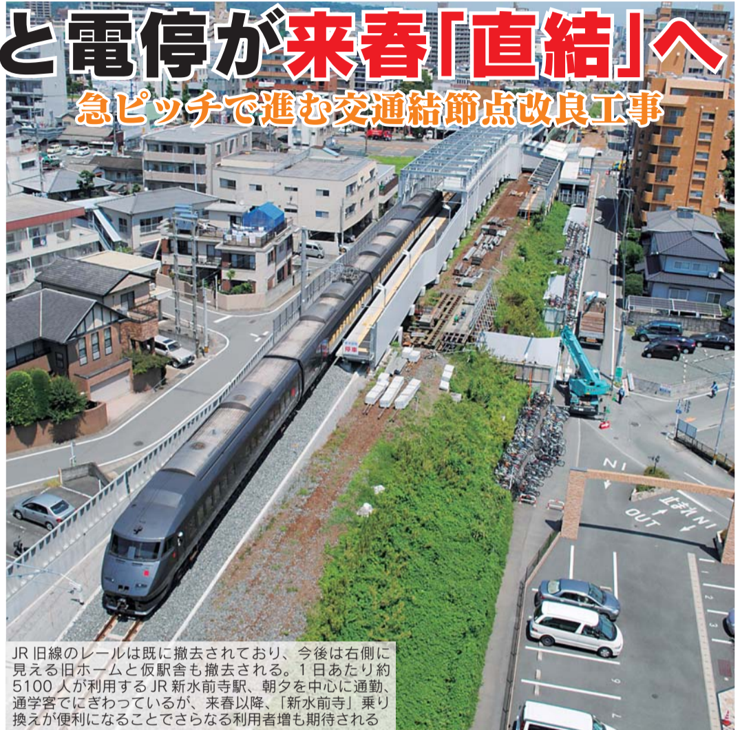
JR 旧線のレールは既に撤去されており、今は右側に見える旧ホームと仮駅舎も撤去される。1日あたり約5100人が利用するJR新水前寺駅、朝夕を中心に通勤、通学客でにぎわっているが、来春以降、「新水前寺」乗り換えが便利になることでさらなる利用者増も期待される
