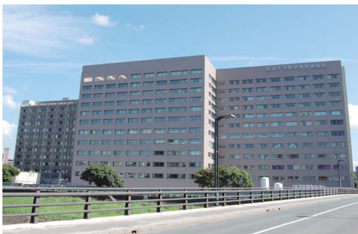
▲地上12階地下1階建ての東病棟
