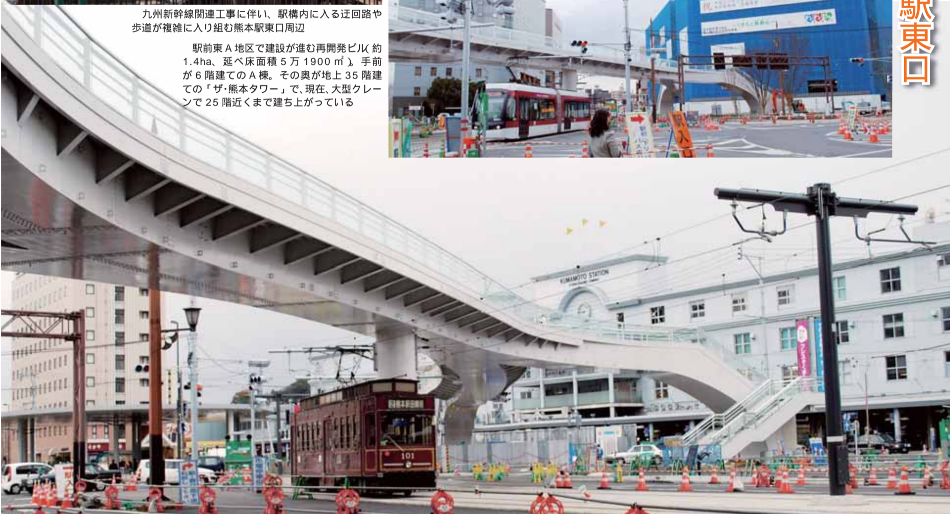
現駅ビル「フレスタ」前には、扇状の大屋根や熊本駅と駅前再開発ビルを結ぶペDESTリアンデッキが架設され、熊本の新しい顔づくりが急ピッチで進んでいる
