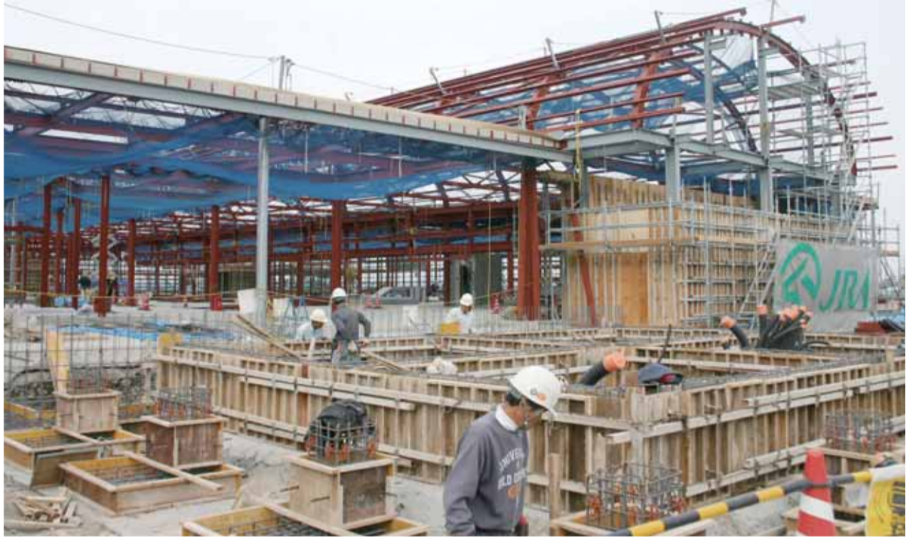
現在鉄骨が組み上がり、12月には内外装と、電気設備工事にも着手する予定。写真は建物東側から撮影
