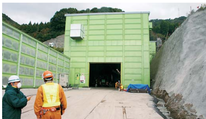
▲昨年11月に着工した津奈木トンネルの坑口
