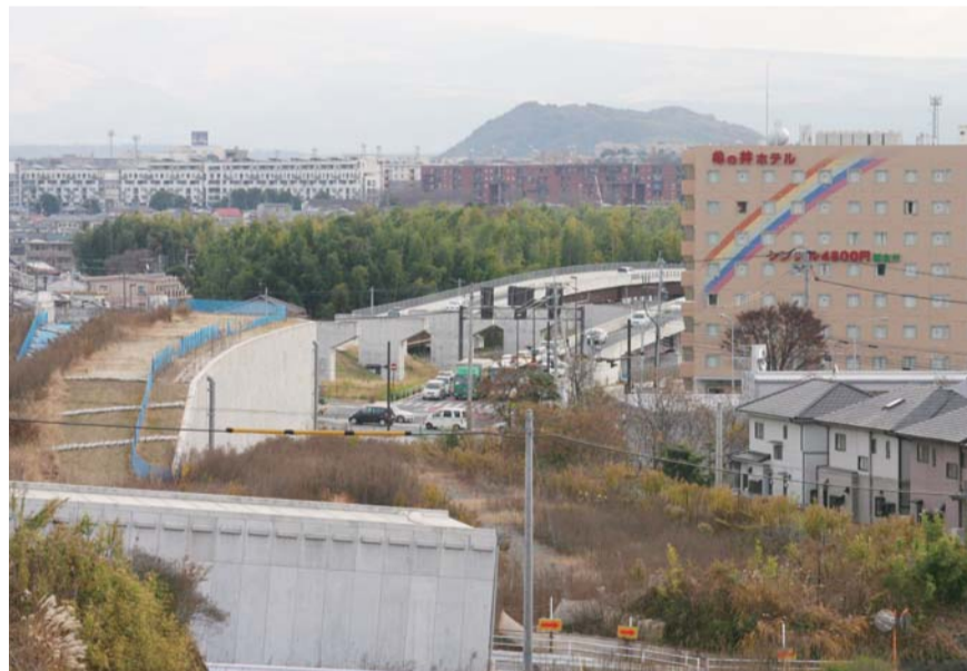
▲熊本市鶴羽田の現場と国道387号の結節点。
