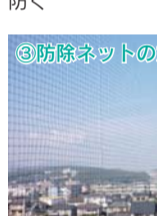
③防除ネットの施工例
