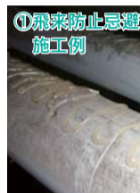
①飛来防止忌避剤「ハートジェル」の施工例
