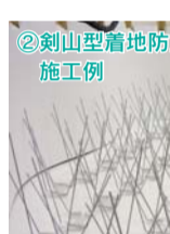
②剣山型着地防止プロテクターの施工例
