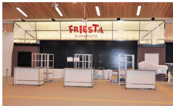
▲1階の南側部分の商業施設「フレスト熊本」の入り口。奥では入居テナントが最後の仕上げ工事に
