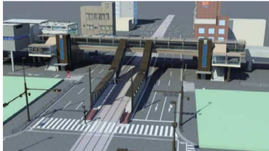
▲新水前寺駅地区の交通結節点改良工事の完成予想図（11年7月末頃のイメージ）。現在、横断歩道橋の屋根などの色合いについては最終的な調整が行われている。左の支柱構造の建物にJR新水前寺駅の新駅舎、写真奥方向が「味噌天神前」方面
