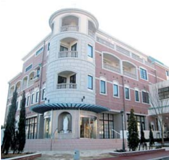
▲完成した5階建て新産科棟「マリア館」
