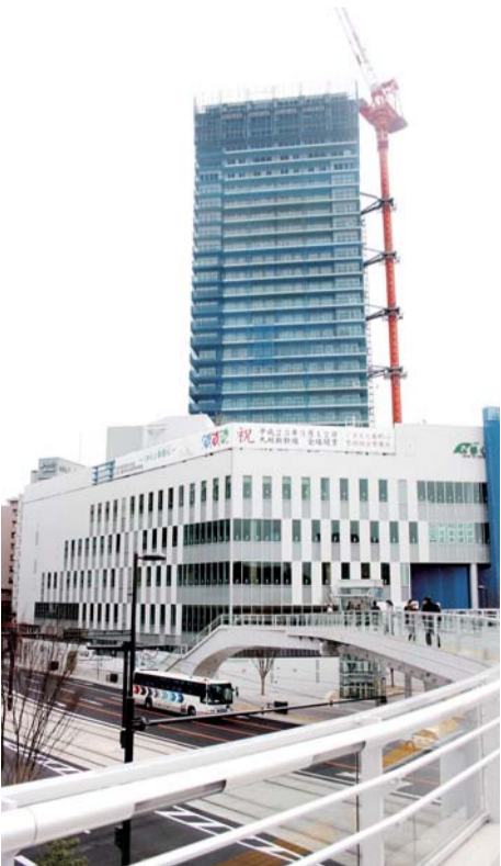
▲東口の道路を隔てたところに建設中の再開発ビル「くまもと森都心」
