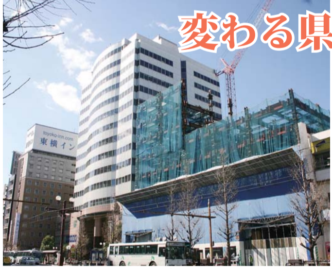
▲東千石町の電車通り沿いで工事が進む大阪市の（株）阪急神ホテルズの 13 階建て「レム鹿児島（仮）」（251 室）。11 年 10 月のオープン予定。商工会議所ビル「アイム」を挟み先発組の「東横イン」がある
