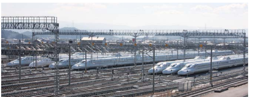
▲熊本市富合町の JR 九州熊本総合車両所に駐機する新幹線車両。同車両所は敷地面積が約 20ha で JR 西日本の博多総合車両所、JR 東日本の仙台総合車両センターに次ぐ全国 3 番目の規模。熊本市の“産業観光”の拠点としても期待されている
