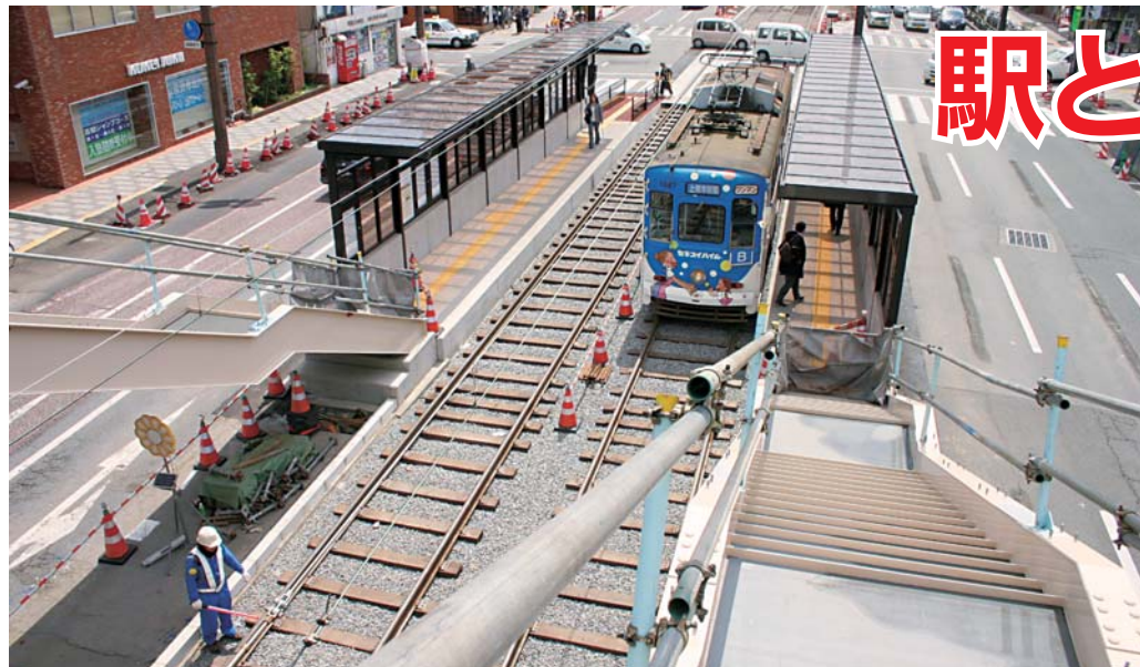
▲市電電停に続く歩道橋。完成は7月末を予定している
