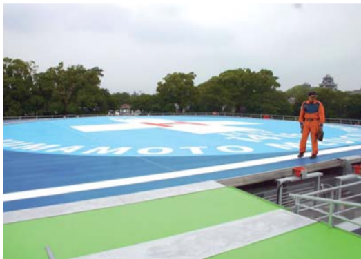
正面玄関前に新設したヘリポート。地上高は10mで床面積は625㎡。総工費は約1億7千万円(このうち約1億円は国庫補助)
