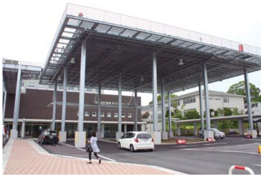
正面玄関前に新設したヘリポート。地上高は10mで床面積は625㎡。総工費は約1億7千万円(このうち約1億円は国庫補助)
