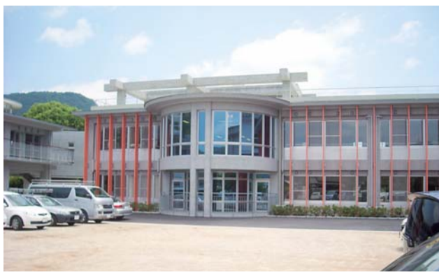
▲特別養護老人ホーム「こもれび」東側に建設した別館
