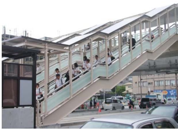
▲歩道橋の延長は65m、幅は3.5m。雨天時もぬれずに乗り換えてできる
