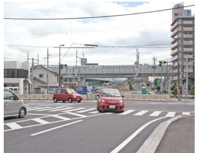
▲道路整備が進む田崎陸橋付近。田崎方面を背に二本木方面に向かって撮影。左手が熊本駅方面
