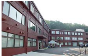
▲同院北東側に新設した第3北棟
