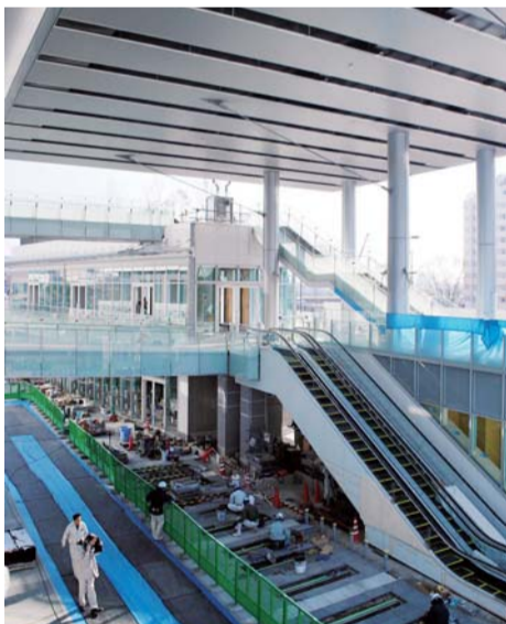
▲くまもと森都心プラザとB棟には2階と3階屋上庭園を結ぶ空中通路を設ける
