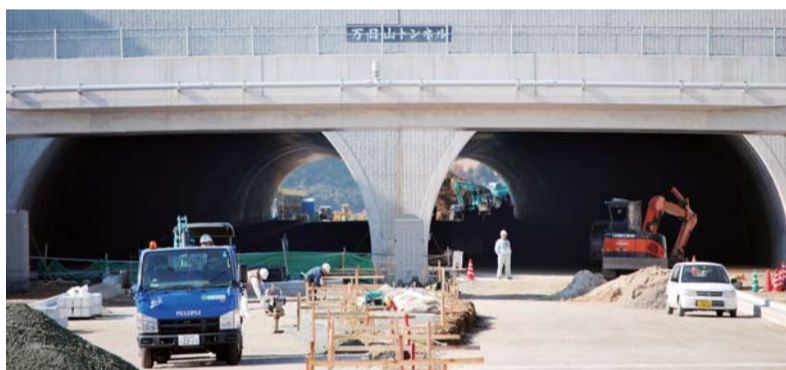
▲来年3月に4車線で供用を開始する都市計画道路「春日池上線」の万日山トンネル（全長445m）。坑道奥に見えるのは池上町方向
