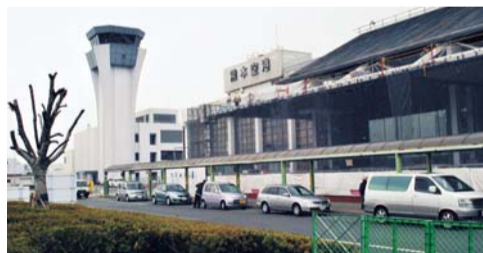
▲拡張工事第2段階の終盤を迎えた空港ビル。駐車場側から撮影
