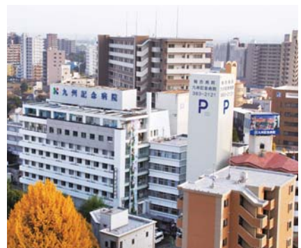
▲完成した新立体駐車場(右)と病院本館(左)
