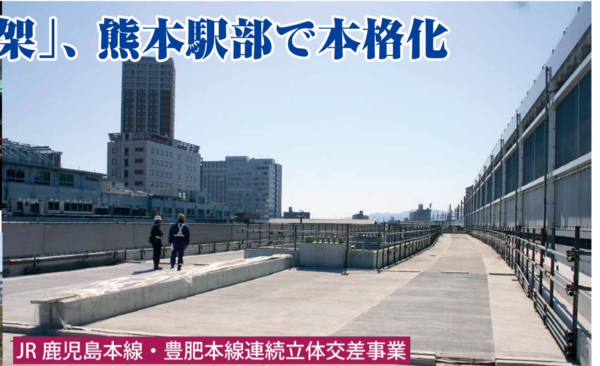
▲駅部分となる高架橋。写真中央、柵がある所がホームとなる。地上から写真の人が立つコンクリート面までの高さは7.5m。右は新幹線ホーム。奥に合同庁舎A棟、JR九州ホテル熊本、東横イン熊本駅前
