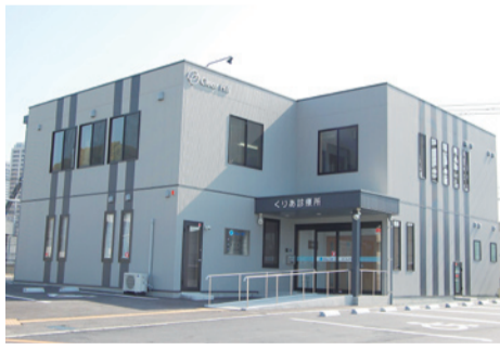
▲春日7丁目の新幹線口南側に開院した「くりあ診療所」
