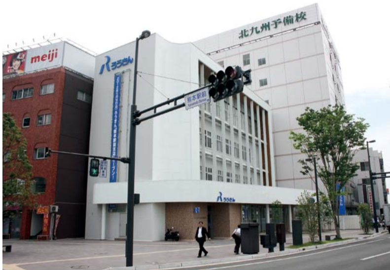
▲5月にオープンした九州労働金庫熊本駅前支店
