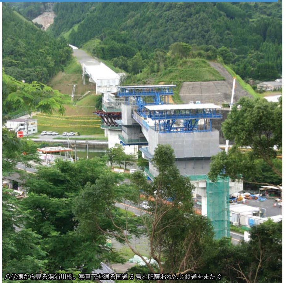
◀同橋の桁工事は「張り出し架設工法」と呼ばれ、4m×5mずつコンクリートを打設し桁を延ばしていく工法が採用されている
