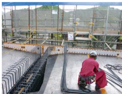
◀同橋の桁工事は「張り出し架設工法」と呼ばれ、4m×5mずつコンクリートを打設し桁を延ばしていく工法が採用されている
