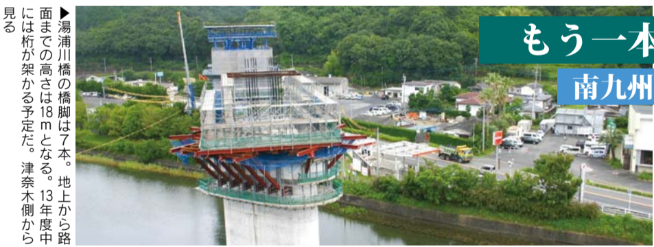
◀同橋の桁工事は「張り出し架設工法」と呼ばれ、4m×5mずつコンクリートを打設し桁を延ばしていく工法が採用されている
