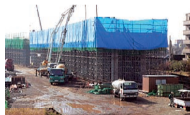
▲熊本駅構内の西側寄りで本格化している杭打ち作業。新幹線高架橋の土台になる。大型作業車で直径120センチ程度のケーシングパイプ(外筒)を継ぎ足しながら地下30mまで打ち込み、その中に円筒形に組んだ鉄筋を入れコンクリートを流し込む
