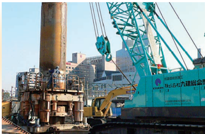
▲熊本駅構内の西側寄りで本格化している杭打ち作業。新幹線高架橋の土台になる。大型作業車で直径120センチ程度のケーシングパイプ(外筒)を継ぎ足しながら地下30mまで打ち込み、その中に円筒形に組んだ鉄筋を入れコンクリートを流し込む
