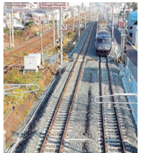
▲移設した1次仮線(約4km)を走る鹿児島本線のつばめ。旧線路(写真左側)上に新幹線高架橋を建設後、再び在来線を高架橋下に設ける2次仮線に移し在来線高架橋を建設する。写真は市道段山島崎線の段山陸橋から上熊本駅方向を写す
