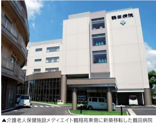
▲介護老人保健施設メディエイト鶴翔苑東側に新築移転した鶴田病院
