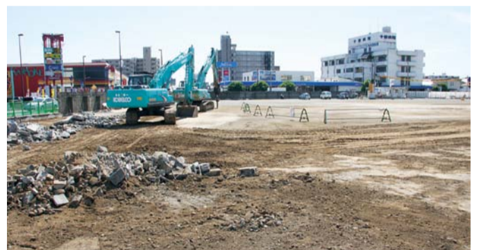
▲食品スーパーのハローデイなどが入居する「NNTTAP南熊本複合店舗（仮称）」の建設現場（熊本市中央区南熊本3丁目）
