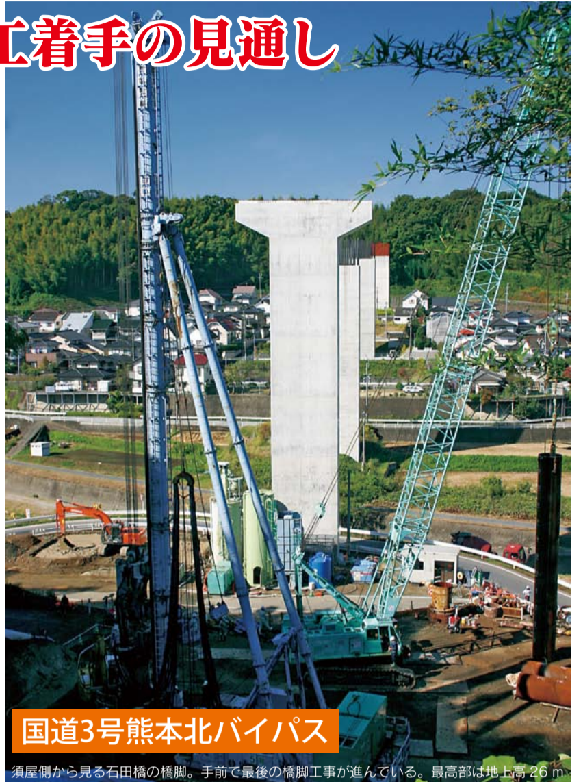
右写真の橋脚工事は10月現在で基礎となる杭打ちが進行中。強度を高めるため、地下に埋め込む杭は深さ40m以上となる
