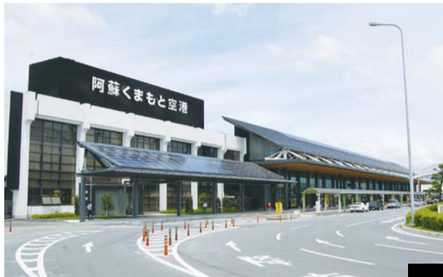
▲熊本城の城郭をイメージした外観の国内線ターミナルビル。阿蘇くまもと空港の大看板も新たに設けられた
