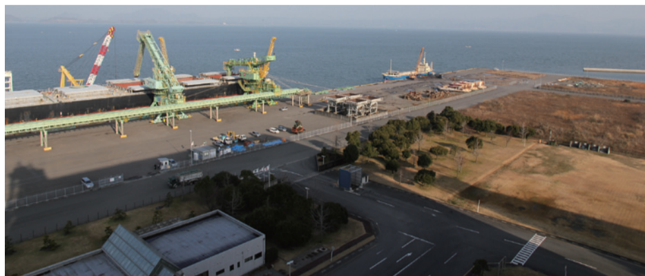
▲穀物輸入のバシフィックグレンセンター八代支店前の「第1バース」に停泊するアルゼンチンからの飼料船。6万トン超のバナマックスサイズだが、積み荷を調整し入港している。14m化でこうしたロスが解消できるという。船の裏手にしゅんせつ用の作業船、第2バースは右手、小型の船が停泊する辺りとなる。
