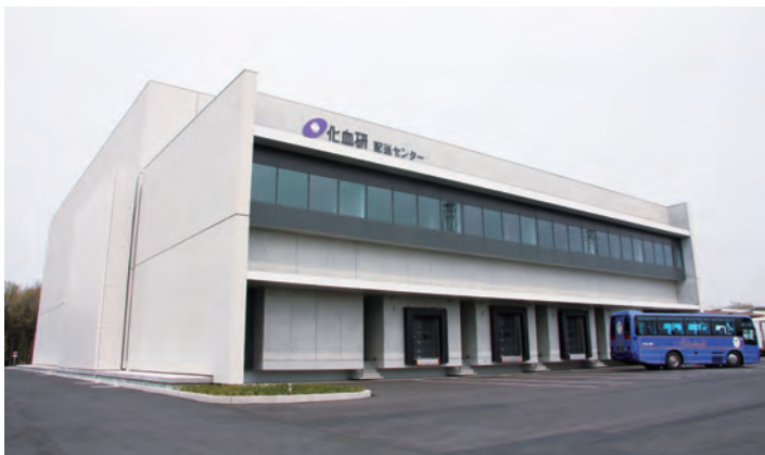
▲約29億円を投じFC棟と共に完成した菊池研究所敷地内の新配送センター。建物は免震構造で、+2℃～5℃の高精度の温度管理で約2000万人分のワクチンを保管できる立体自動倉庫を備える
