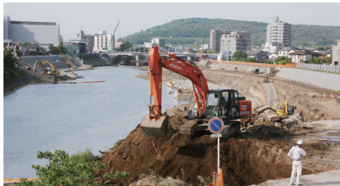
▲明午橋から上流の工事を望む（正面は子飼橋）。白川の形状で護岸の形も変わるが、自然石が使われ景観に統一感がある
