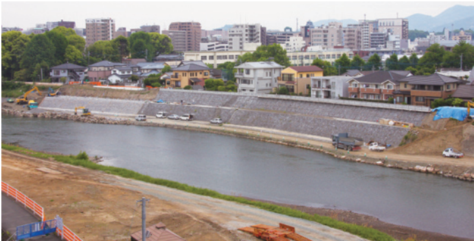
▲子飼橋下手右岸（東子飼町、井川淵町）でも石垣護岸の整備が進んでいる
