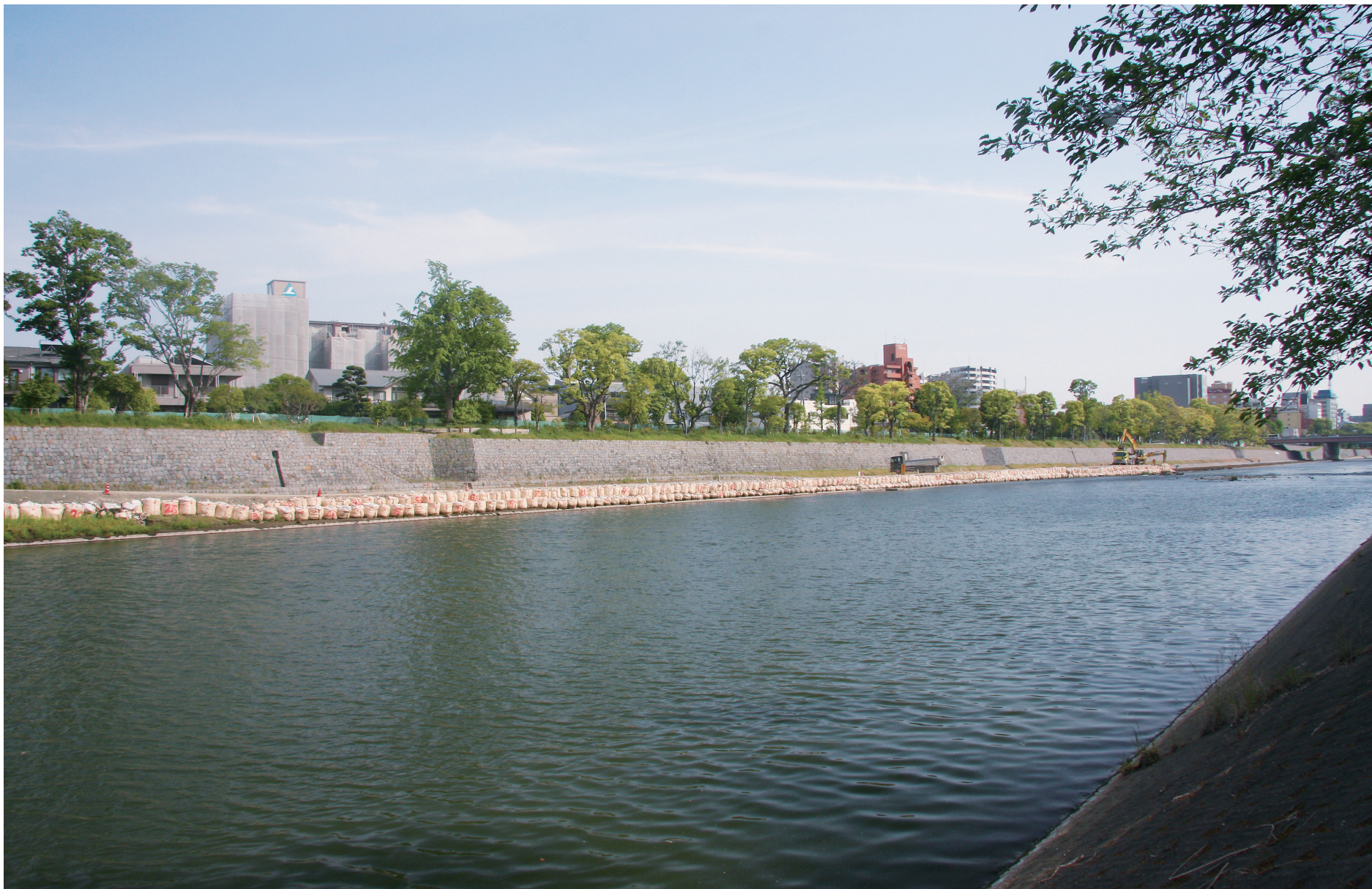
▲「第二の長堀」的な景観を見せる大甲橋上手左岸（新屋敷側）に姿を現した石垣造りの親水護岸
