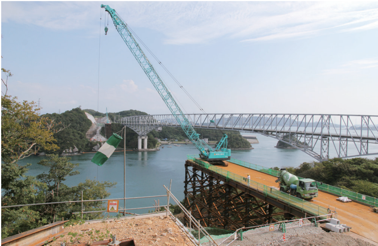
▲大矢野バイパスのヤマ場となるアーチ橋「新天門橋」(仮称、延長463m)は、橋台の基礎工事中でアーチが姿を現すのは15年頃の見込み
