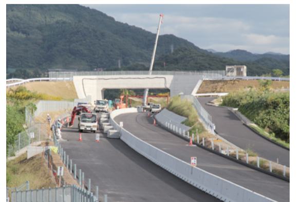
▲今年度内供用へ工事が大詰めを迎えている九州横断道延岡線「嘉島JCT~小池高山IC」間(1.8km)
