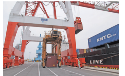
▲コンテナを積み下ろす熊本港のガントリークレーン。この設置で作業時間も短縮されている
