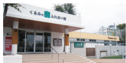
11月から順次オープンしている同施設の「ふれあい棟」。棟の東側に住宅型有料老人ホームを建設中
