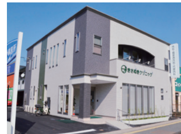
本荘町に移転した「きさぬきクリニック」
