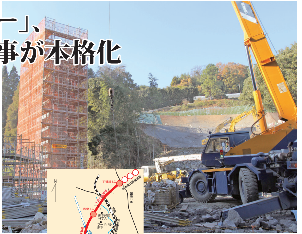
▲延長1005mの下硯川高架橋。13年度内にも上部工事に着手する。現在は調整池の整備などが進んでいる
