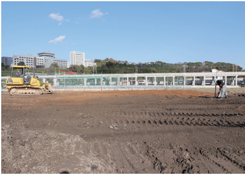
▲花園インター線は西区の池亀町と池田4丁目、花園7丁目を通る。写真は池亀町で進む盛土。後方に九州新幹線高架、崇城大学
