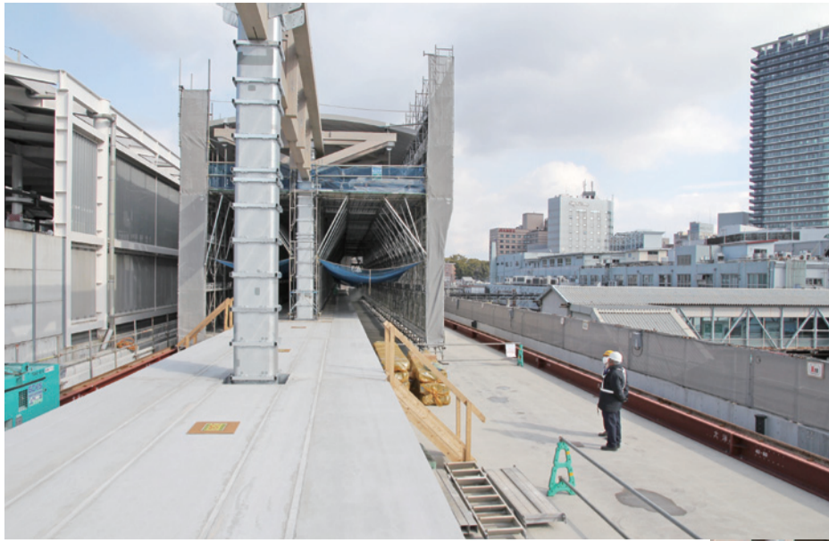
▲幅約4～8mのホームは、線路から0.96～1.1mの高さ
