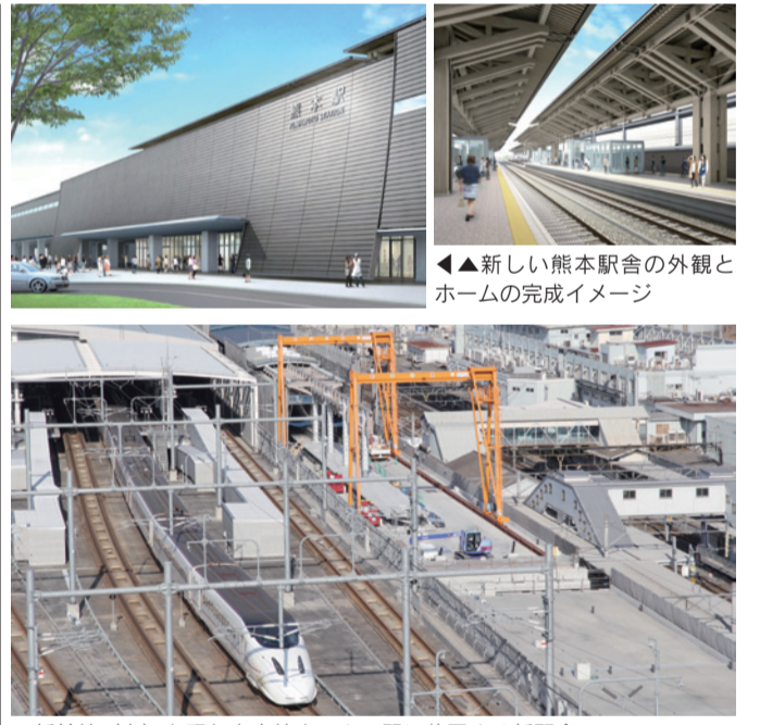
▲県産のアカマツやスギを使用したホーム。人が立つ付近にレールが敷かれる。今後建設される下り線の高架（ホーム）は写真右手となる
