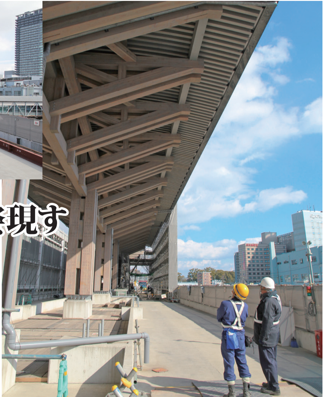
▲県産のアカマツやスギを使用したホーム。人が立つ付近にレールが敷かれる。今後建設される下り線の高架（ホーム）は写真右手となる
